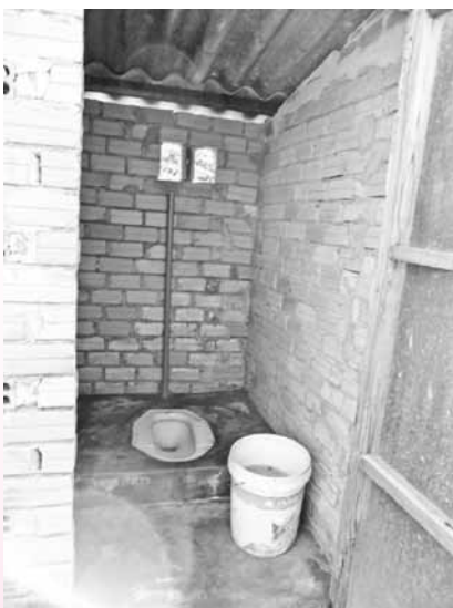
Nhà tiêu thấm dội nước hợp vệ sinh được xây từ nguồn vốn hỗ trợ từ chương trình NS&VSMNTT tại huyện Long Điền.
