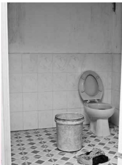
Nhà tiêu thấm dội nước hợp vệ sinh được xây từ nguồn vốn hỗ trợ từ chương trình NS&VSMNTT tại huyện Long Điền.
